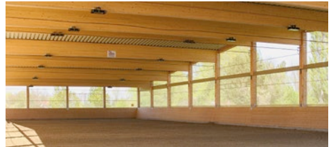
Diese OPENAIR -Halle ist mit einer Bande von GROHA und Windschutznetzen ausgestattet.
