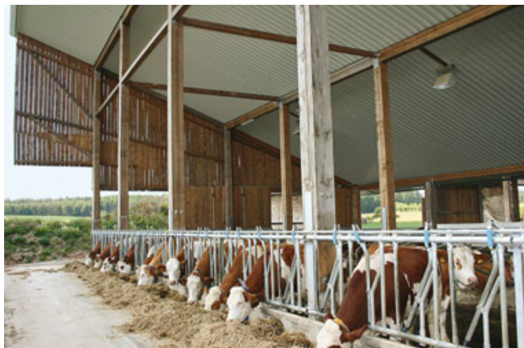
Auf der Südseite ist das Dach bis zu 9 m hoch. Die Giebelseiten sind nur zum Teil mit Brettern verschalt.
