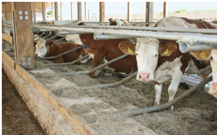
Der betonierte „Kopfkasten“ überragt die Lauf- und Liegeflächen um 45 cm. Die Boxen sind nur 1,20 m breit.
